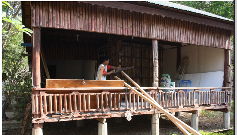
Ancienne maison de Denis, en travaux, mai 2016
