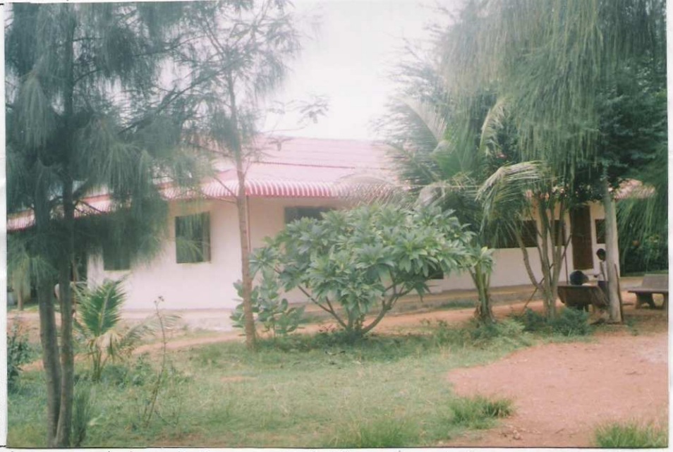
le nouveau bâtiment bureau / réfectoire don de L'ARE Montpellier
