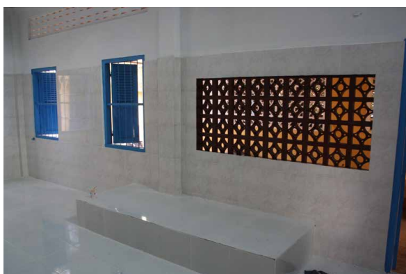
Peinture des fenêtres et de toutes les portes de la cuisine. Pose du carrelage et peinture des murs en blanc, pour rendre la pièce plus lumineuse.
