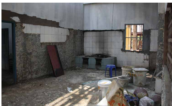
Rénovation de la cuisine du Foyer Lataste: Installation de nouvelles fenêtres, remplacement du carrelage, destruction des éviers et peinture intérieur et extérieur.
