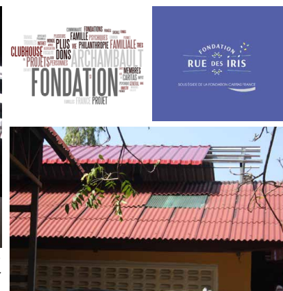
Réhaussement du toit et installation de tôles transparentes pour un meilleur éclairage.
