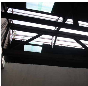
Réhaussement du toit et installation de tôles transparentes pour un meilleur éclairage.
