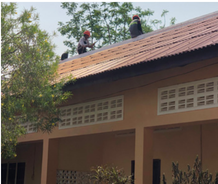
Installation des panneaux solaires
