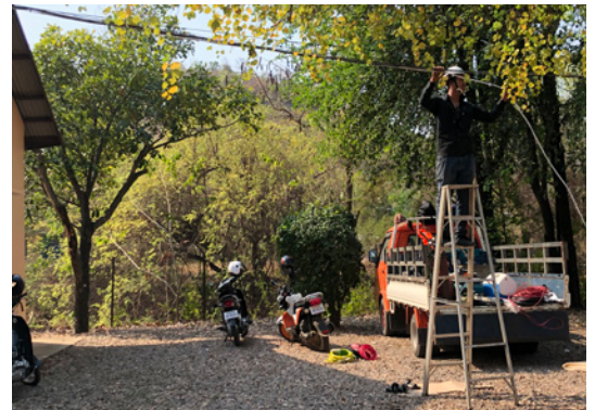
Raccordement au second bâtiment
