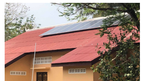
8 panneaux posés sur le toit du bureau
