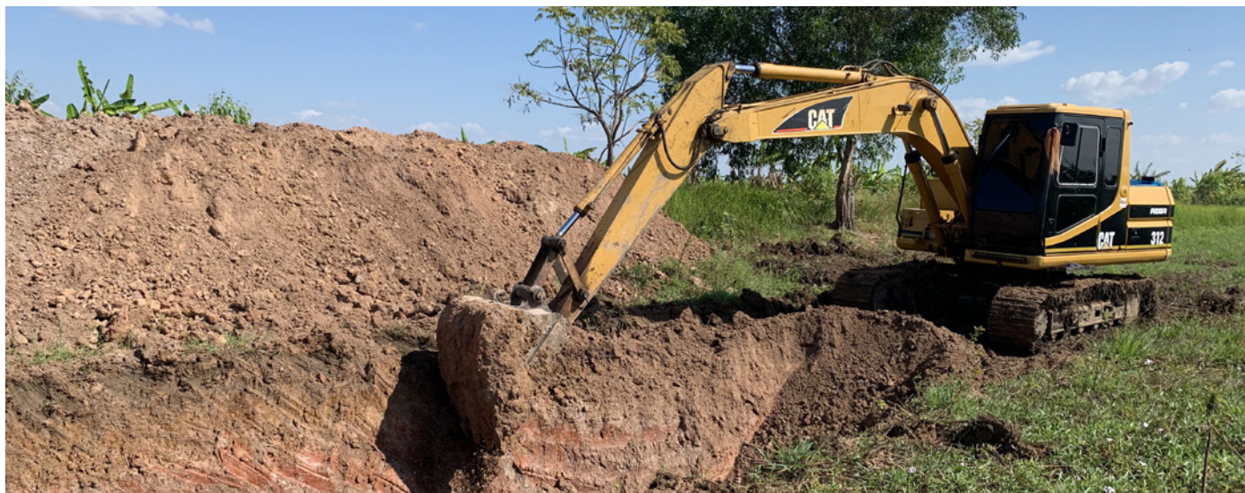
Début des travaux à l'éco-ferme
